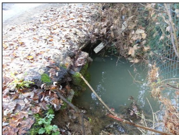
Foto 17 – Loc. S.P. 158 - Imbocco attraversamento che convoglia le acque relative all'impluvio minore defluenti dal contesto collinare a monte di V.la Ada verso valle (10-12-2014).
