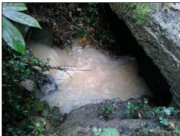
Foto 15 – Loc. S.P. 158 in corrispondenza dei civici 17-18 - Collettore delle acque relative all'impluvio minore defluenti dal contesto collinare a monte di V.la Ada. A destra l'immissione nell'attraversamento sotto la S.P. 158 (13-11-2014).
