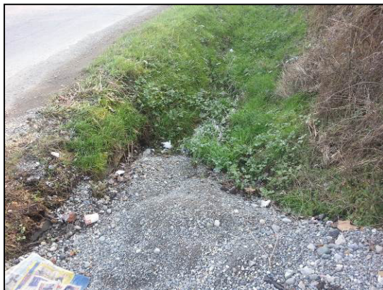
Foto 48 - S.P. 35bis carreggiata direzione Serravalle – Loc. accesso Bufalora – imbocco totalmente occluso dell' attraversamento che convoglia le acque delle cunette stradali sotto la S.P. (8-1-2015).
