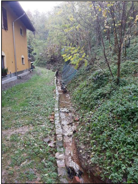
Foto 11 – Fosso coerente alla vecchia strada Ospedale impostato a taglio sulla scarpata di terrazzo visibile a destra nella foto. Tratto di valle a tergo dei fabbricati di Via Valgelata (13-11-2014).
