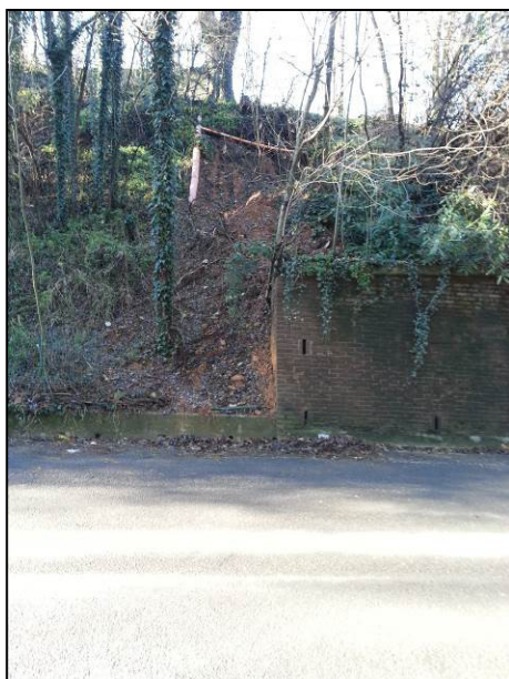
Foto 1 – Erosione per dilavamento concentrato in corrispondenza della scarpata in Via Antica Genova (13-11-2014).
