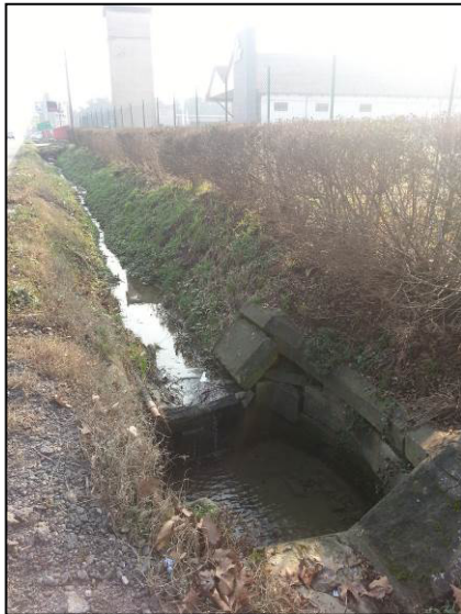
Foto 46 - S.P. 35bis carreggiata direzione Serravalle – Loc. accesso Villa Minerva – imbocco attraversamento che convoglia le acque delle cunette stradali sotto la S.P. (8-1-2015).
