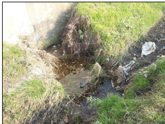
Foto 49 - S.P. 35bis carreggiata direzione Novi – Serravalle – uscita attraversamento Foto 52 ed inizio canalizzazione zona produttiva con imbocco totalmente occluso (8-1-2015).
