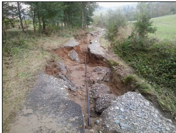
Rio Gavalusso (13-10-2014) – Erosioni in sponda orografica destra Loc. C. Cascinetta.
