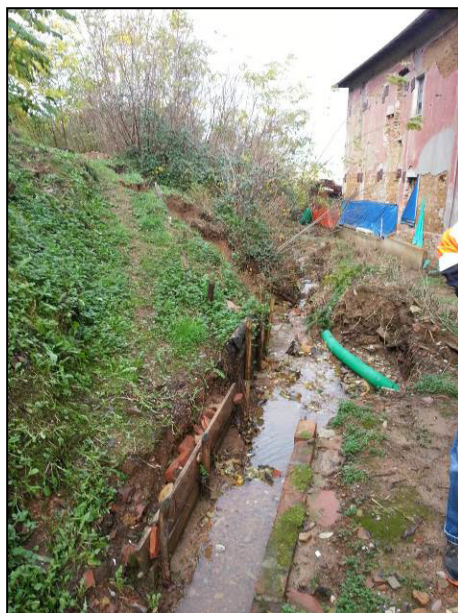
Foto 13 – Fenomeni erosivi causati dal dilavamento delle acque lungo il fosso coerente alla vecchia strada Ospedale. Tratto di valle a tergo dei fabbricati di Via Valgelata (13-11-2014).
